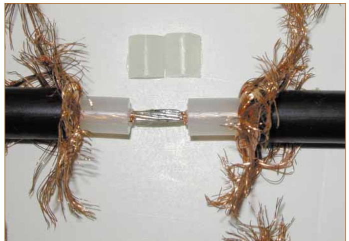
FIGURA NÚMERO CUATRO: CONDUCTORES CENTRALES SOLDADOS.
